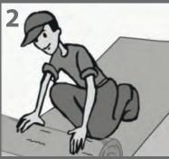
Legen Sie eine Dampfbremse auf den Boden und verschließen Sie die Spalte mit einem Klebeband um eine Feuchtigkeitsbarriere zu schaffen.
